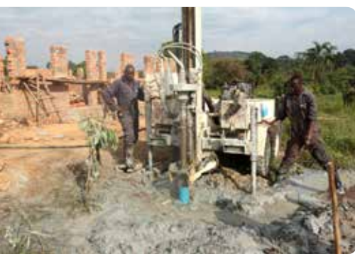
Die Bohrung des Tiefbrunnenloches |
