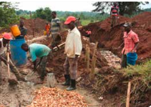
Baubeginn der neuen Schule für Kinder mit Behinderung
