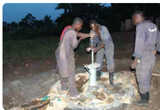
Die Installation des Brunnens |
