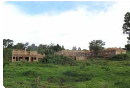
Das Gebäude nimmt Form an
